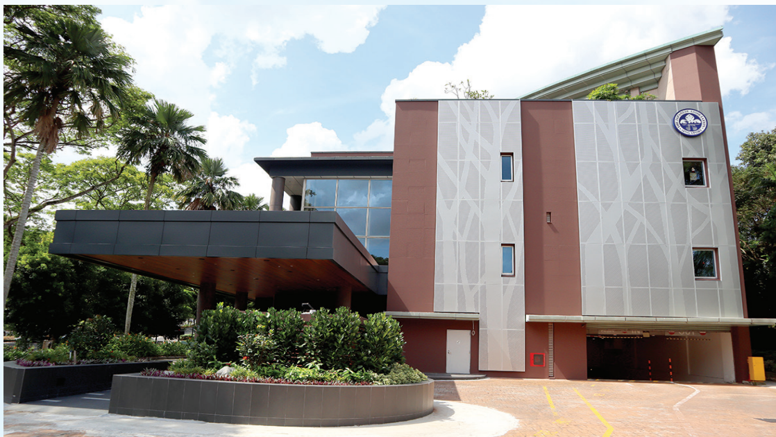
改装後の日本人会館全景
